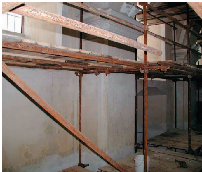
Obr. 4: Nanesení sanační omítky do malé výšky vede k zasolení původních materiálů nad hranici výměny omítek
