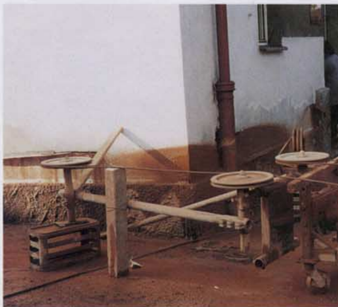
Obr. 2: Podřezávání zdiva lanovou pilou
