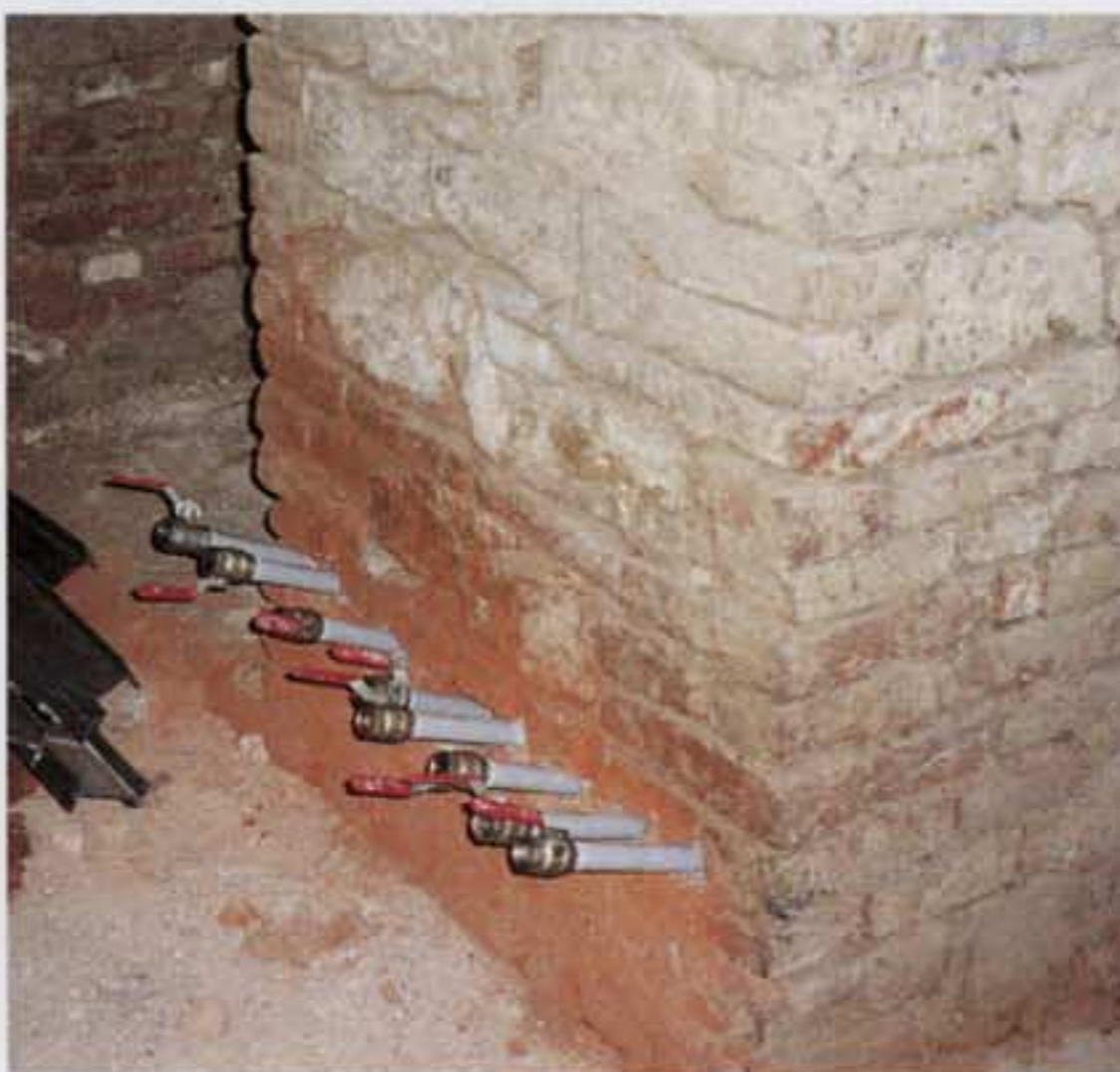
< Obr. 4: Napouštění zdiva injek- tážní látkou z nádobek
