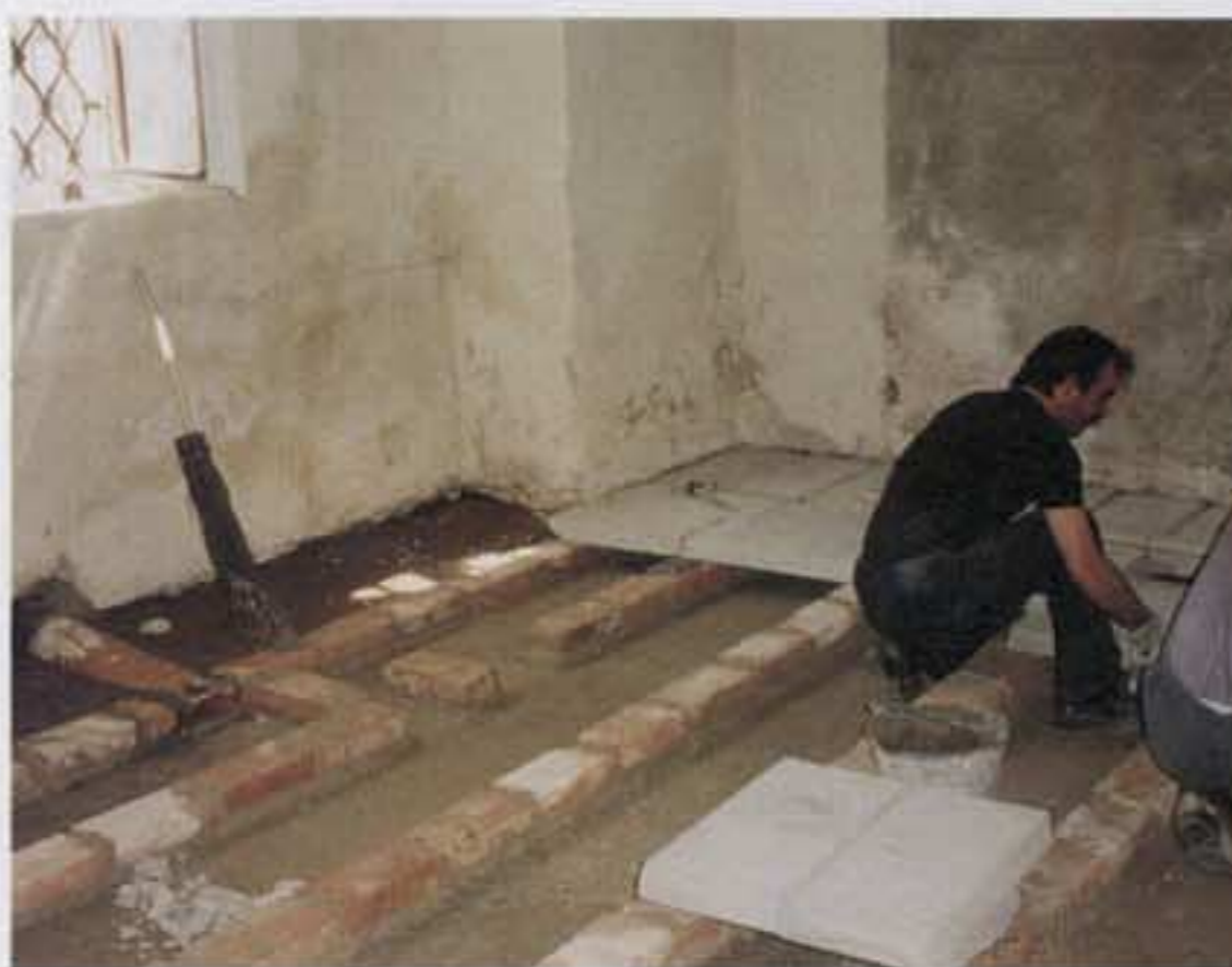
Obr. 1: Vytváření větracích kanálů pod podlahou místnosti
